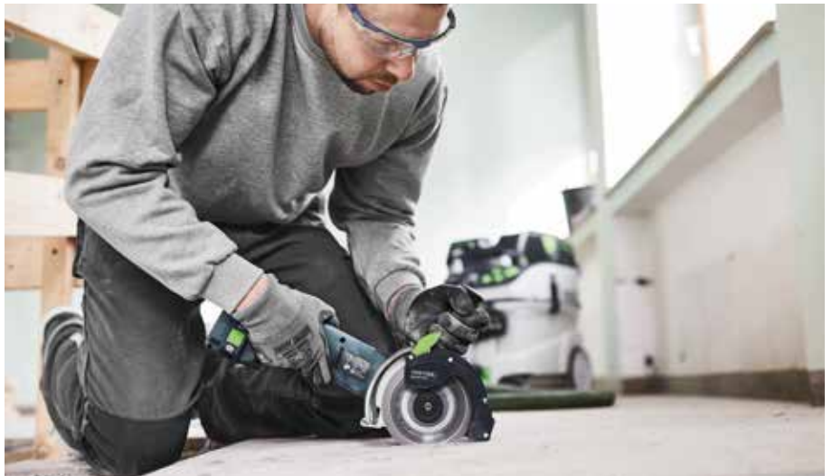
Absaughaube befördert \geq 95\% des Staubs direkt zum angeschlossenen Absaugmobil.
