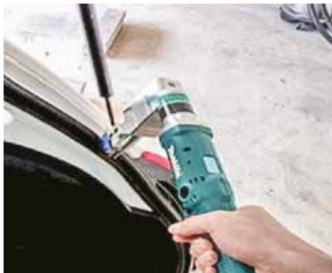
Installation von Dichtungen
