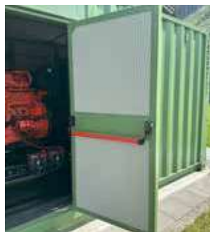
Große Zugangstür auf beiden Längsseiten mit Panikbeschlag
