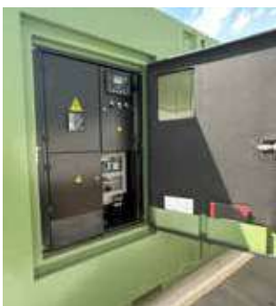
Übersichtliches Bedienfeld hinter versperrbarer Tür mit Sichtfenster
