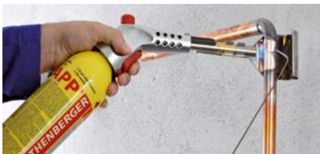
Hartlöten in der Gasinstallation
