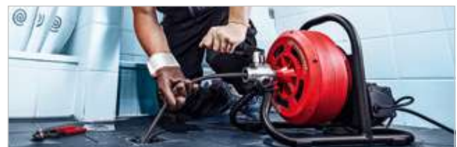
Reinigen eines Bodenablaufes mit 13 mm Spirale
