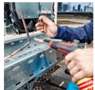
Hartlöten in der Kälte-Klima-Technik
