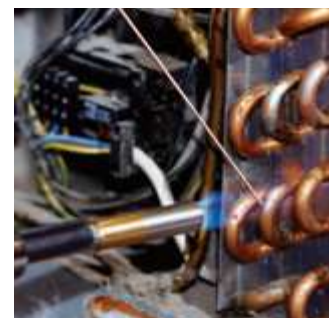
Hartlöten in der Kälte-Klima-Technik
