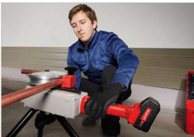
Arbeiten mit einem Dreibein
