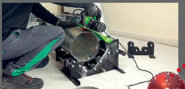
Zeitsparendes Trennen von Lüftungsrohren
