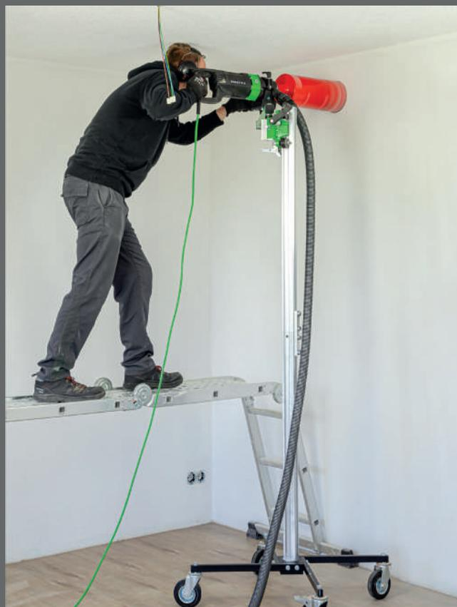
Lüftungsbohrungen bis zu 2,30 m Höhe mit Säulenverlängerung
